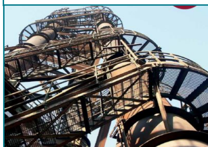
FONDATION BASSIN MINIER
